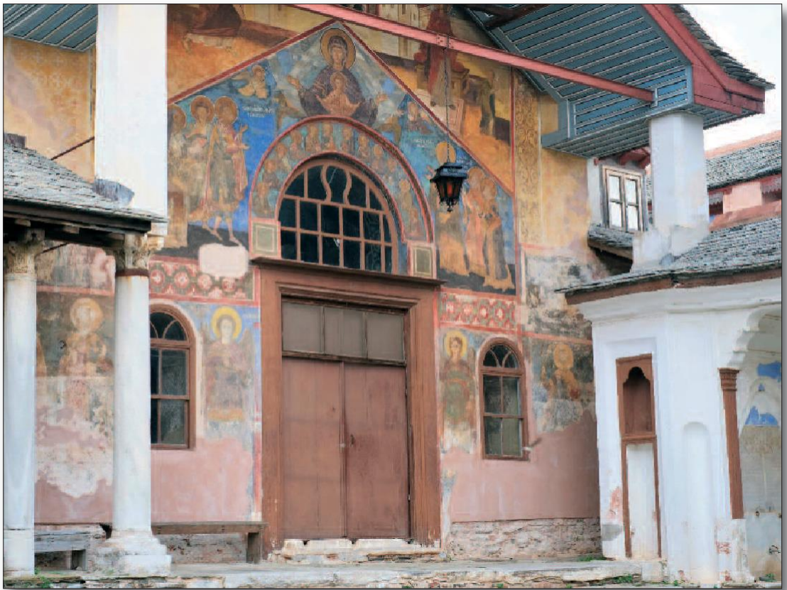
Inngangen til den tusen år gamle spisesalen til klosteret Megistis Lavra. Bygningen er, i den tiden klosteret har eksistert, blitt restaurert mange ganger.
