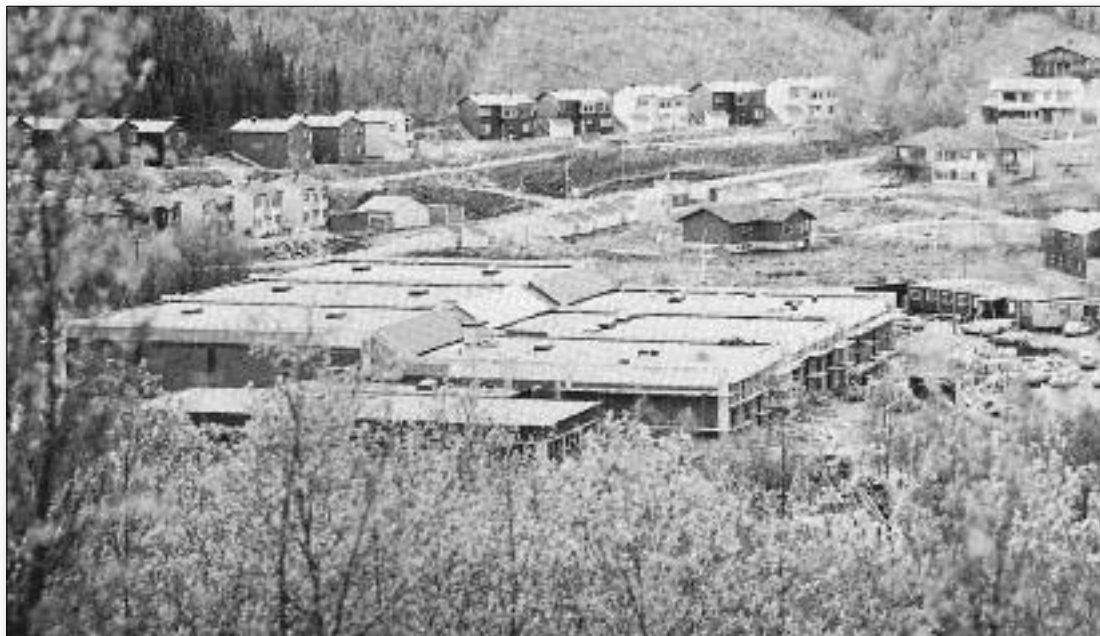
Etter å ha holdt til i leide lokaler fra starten i 1957, kunne avdelingen i Harstad i 1982 flytte inn i eget bygg på Blåbærhaugen, ca. 2 km utenfor sentrum. Foto: NMD.
